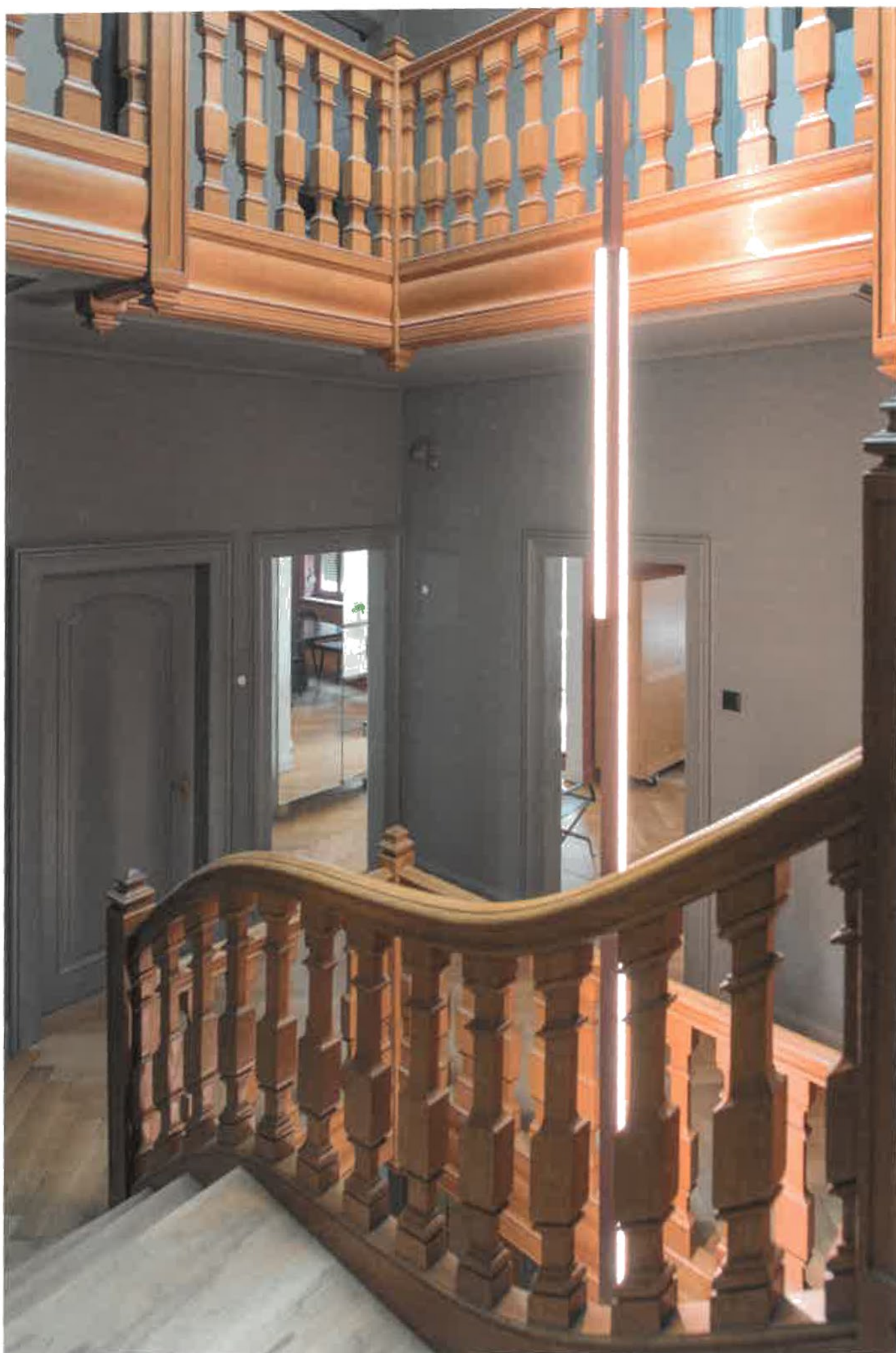
Das Herz der Villa: Mit dem repräsentativen Treppenhaus mit eichenem Balustergeländer und Oberlicht sind alle Zimmer über eine jeweils eigene Tür direkt verbunden.
