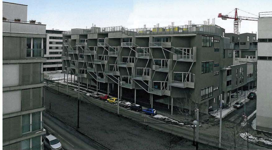
„Casablanca“-Typen an der Tokiostraße: zweigeschöbige Loggien mit Rankgitter warten auf Belebung durch Menschen und Pflanzen “Casablanca“-Units at the Tokiostraße: two-storey-high loggias in a steel structure offer living space in fresh air to people and plants
