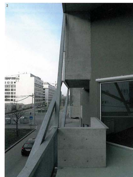
2 Die Tokiostraße aus der „Casablanca“-Loggia-Perspektive Tokiostraße, seen from a "Casablanca"-Loggia
