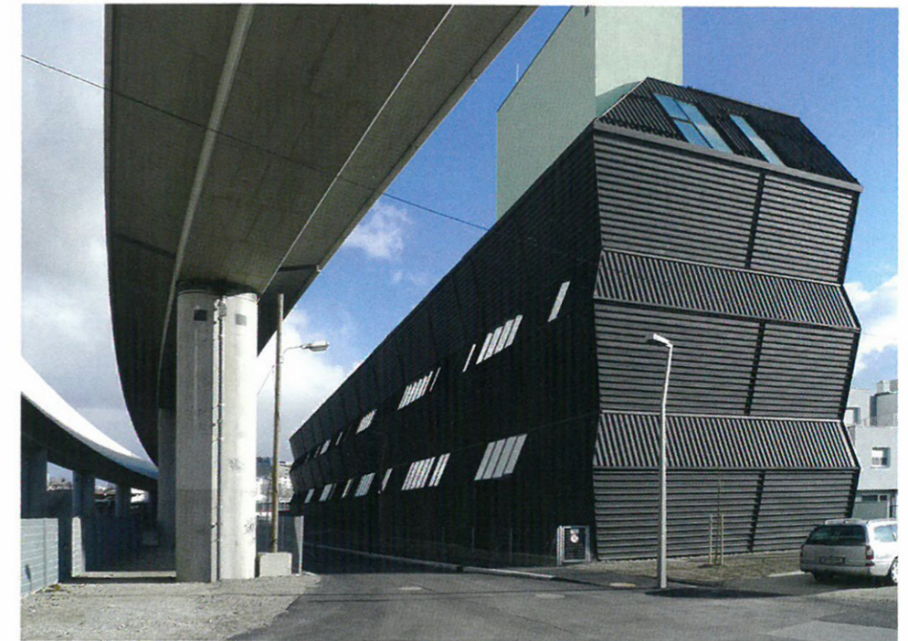
U-BAHN-NÄHE „Generations Wohnen am Mühlgrund“ beherbergt kompakte Zweizimmerwohnungen und eine Pflegewohngemeinschaft im Erdgeschoß. Der siebengeschößige, 90 Meter lange Baukörper verläuft parallel zur U-Bahn-Linie U2 in Wien
